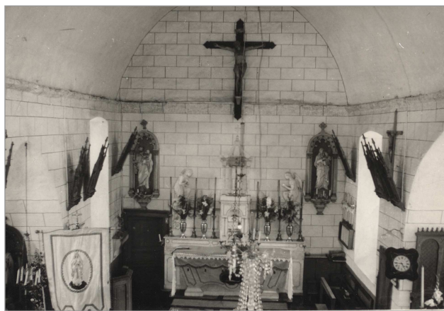
Intérieur de l'église de Bramonas ca 1950
