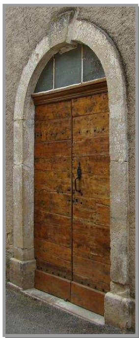
Porte de l'église de Bramonas
